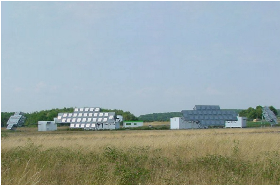
FIGURE 1 – Emetteurs du radar GRAVES, situé entre Dijon et Vesoul. Fréquence d'émission à 143.05MHz.
